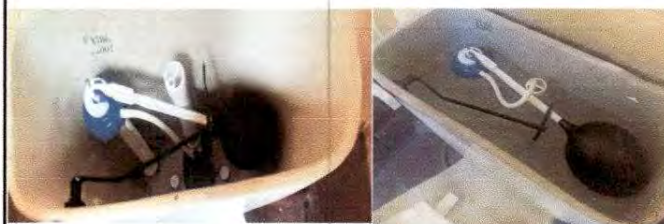
Foto 12: Sustitución de accesorios inodoro para área de baños Módulo 8
