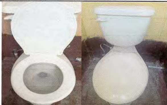
Foto 13: Sustitución de tapaderas en baño Módulo 8
