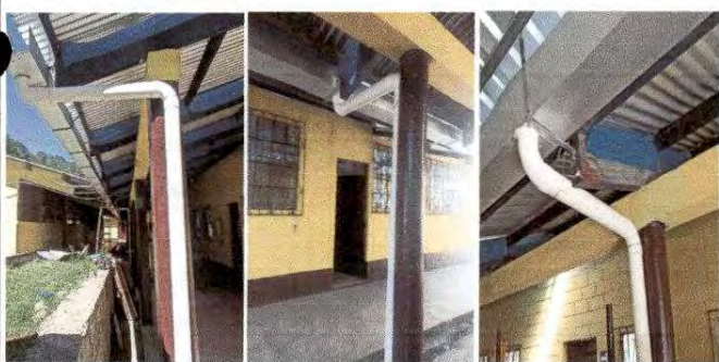
Foto 11: Sustitución y reparación de bajadas de agua pluvial con tubo PVC Módulo 7
