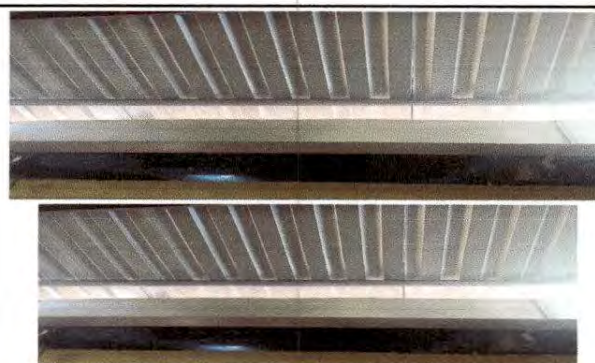
Foto 10: Sustitución de canal de metal por canales de lamina aluzinc calibre 24 con sujetadores en corredores. Módulo 7
