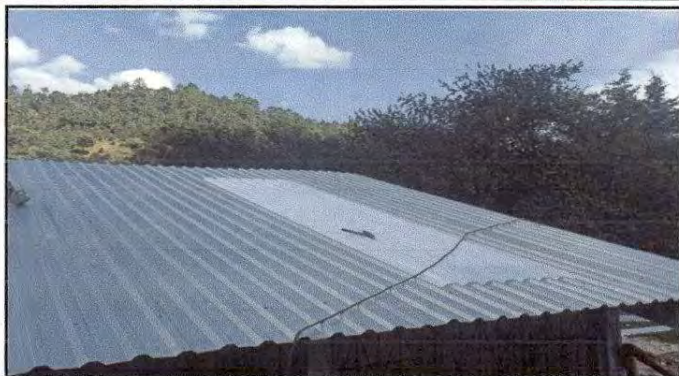
Foto 1: Sustrucion de lamina troquelada aluzinc Módulo 1
