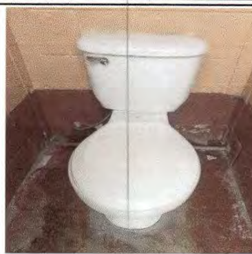
Foto 14: Sustitución de inodoro en baños . Módulo 8
