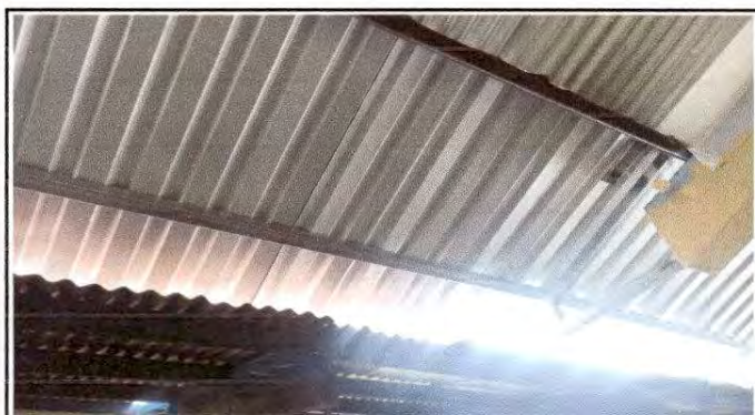
Foto 3: Sustrucion de estructura de soporte de metal por metal en corredores de la escuela. Módulo 3
