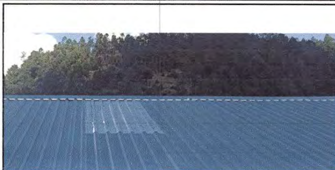
Foto 2: Sustrucion de Capotes por capotes de lamina aluzinc Módulo 1
