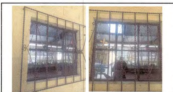
Foto 6: Sustrucion de ventanas de madera por ventanas de metal, más vidrio en un aula. Módulo 5
