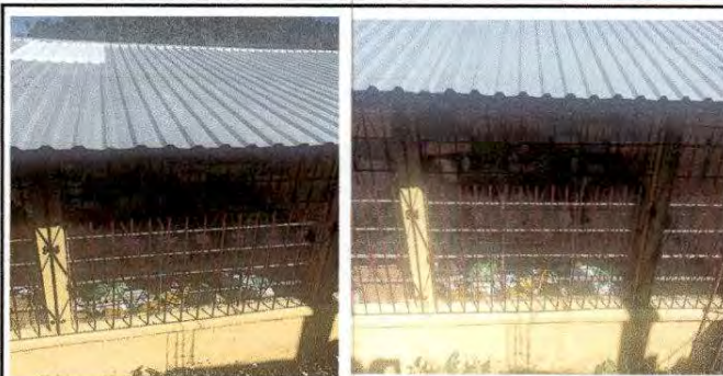
Foto 8: Mantenimiento de balcones en 9 clases. Módulo 6
