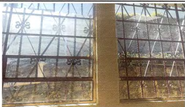
Foto 7: Sustitución de vidrios en ventanales. Módulo 1
